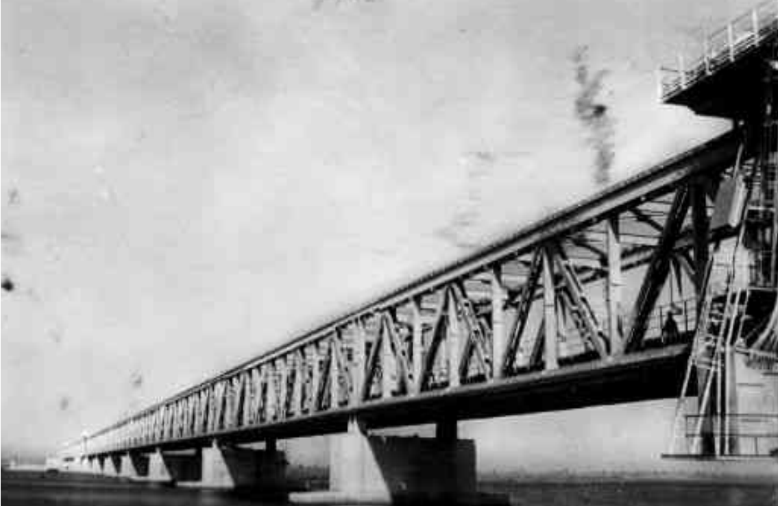
Le barrage hydraulique de Markala (816 m) construit entre 1934 et 1947 (L'illustration du 29 février 1936)
