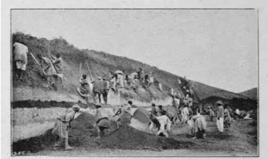
Chantier de terrassement, — Route de Tamatave à Tananarive
