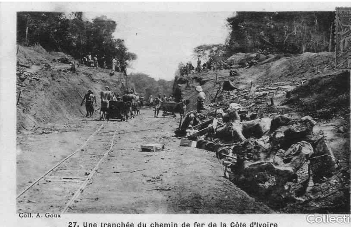
27. Une tranchée du chemin de fer de la Côte d'Ivoire
