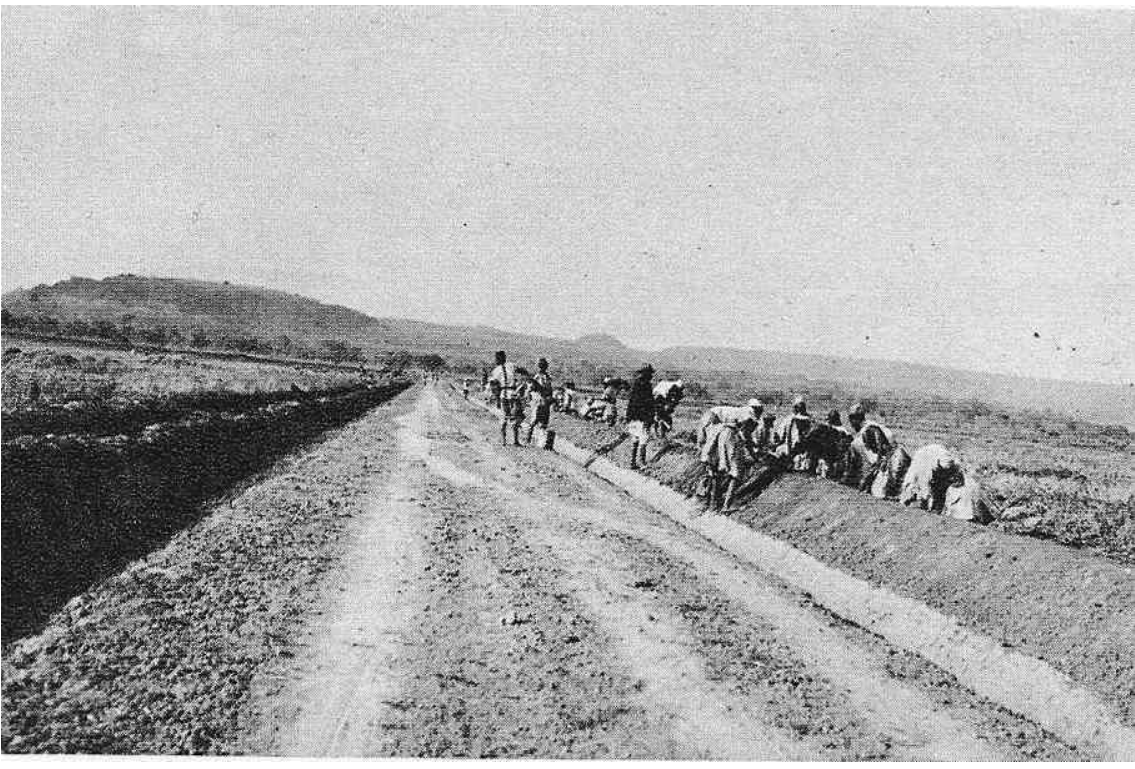
Confection de diguettes pour l'irrigation à Baguinéda (L'illustration du 29 février 1936)
